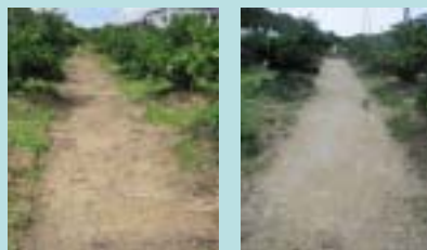
施工前 施工2日後
